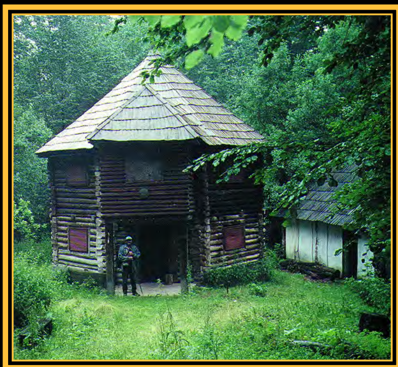
Fig.27. Casă dacică la construcția căreia nu s-a folosit nici un cui
